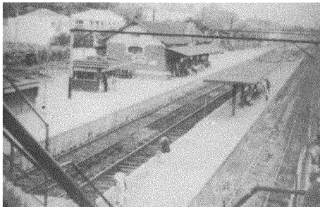
Estação da E. F. C. B.
