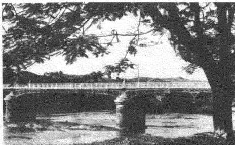
Ponte de Paraíba do Sul.
