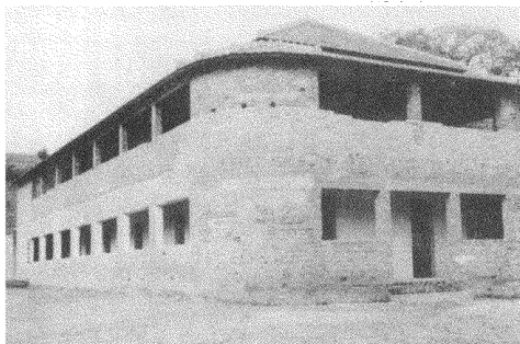
Hospital Asilo de São Vicente de Paulo (em construção).
